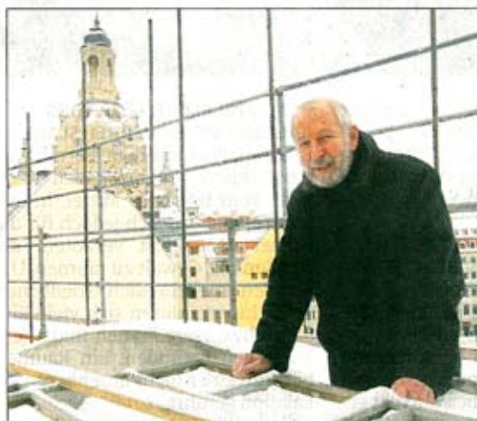
Ipro-Architekt Volker Röhricht zeigt die begonnene Dachkonstruktion. Die Arbeiten ruhen aber derzeit.
