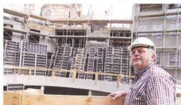
Klaus Eggebrecht hat viel zu tun auf der Großbaustelle am Neumarkt.
